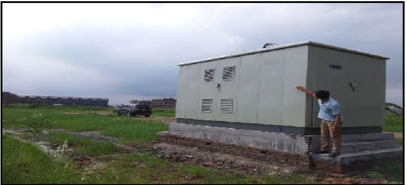
CẤM người không có nhiệm vụ lại gần trạm biến áp
