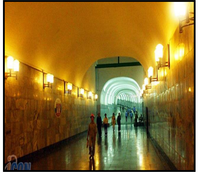
Hệ thống chiếu sáng ở nhà máy Thủy điện Hòa Bình được điều chỉnh theo giờ, theo cường độ ánh sáng
