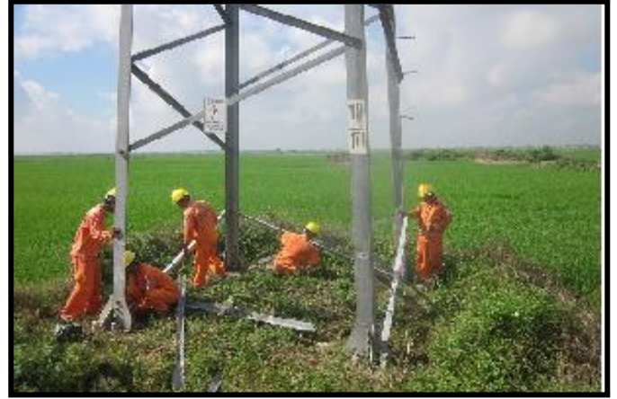
Lắp lại thanh giằng bị mất cắp
