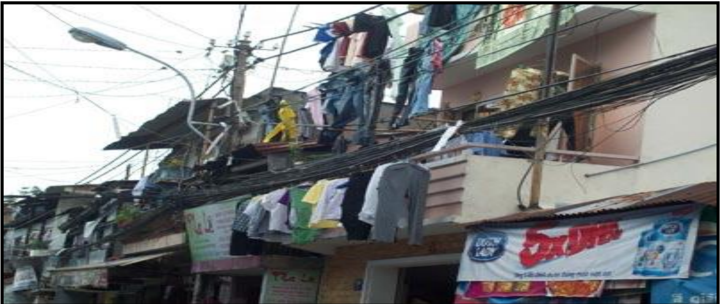
Phơi quần áo trên đường dây truyền tải điện rất nguy hiểm
