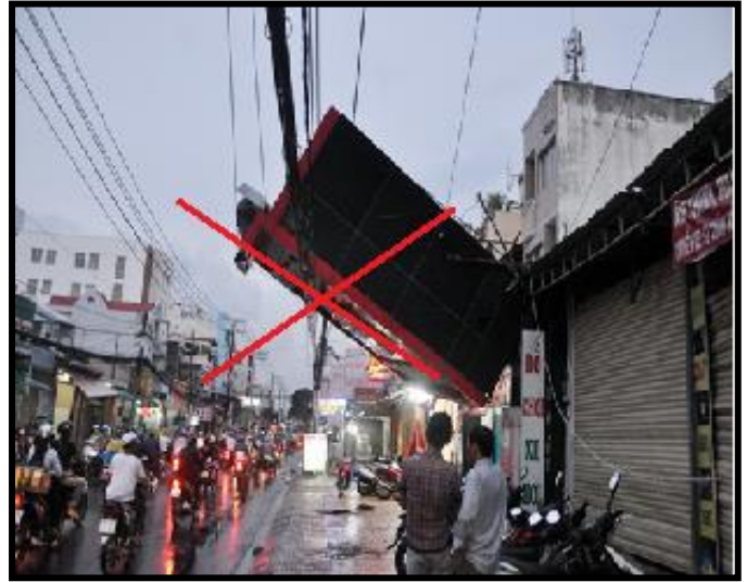
Biển quảng cáo lắp gần dây điện rất nguy hiểm
