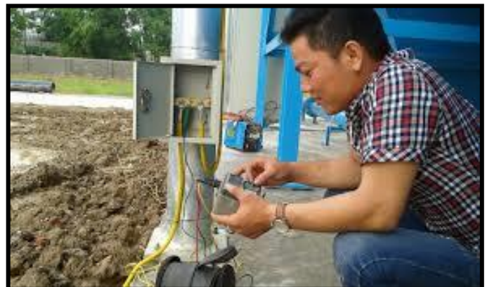
Kiểm tra hệ thống chống sét nếu hư hỏng phải sửa chữa ngay
