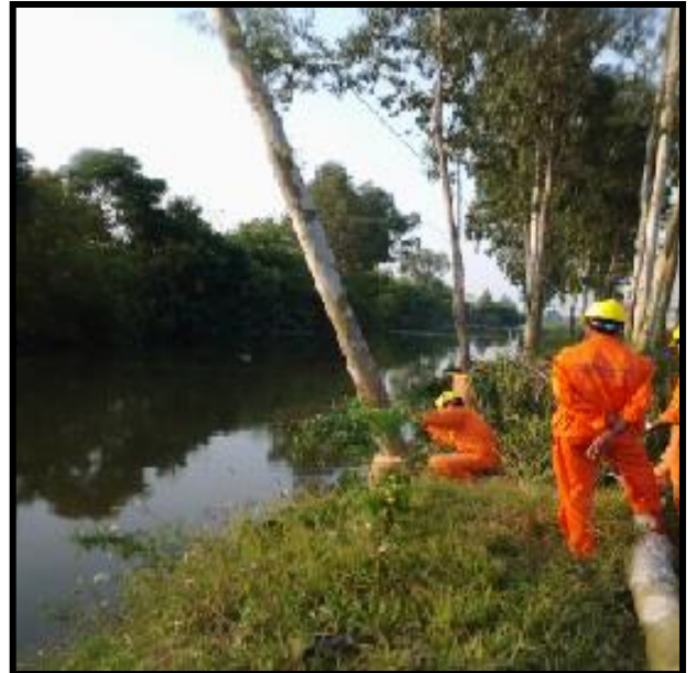
Cây xanh gần đường dây tải điện phải đi chặt để đảm bảo khoảng cách an toàn
