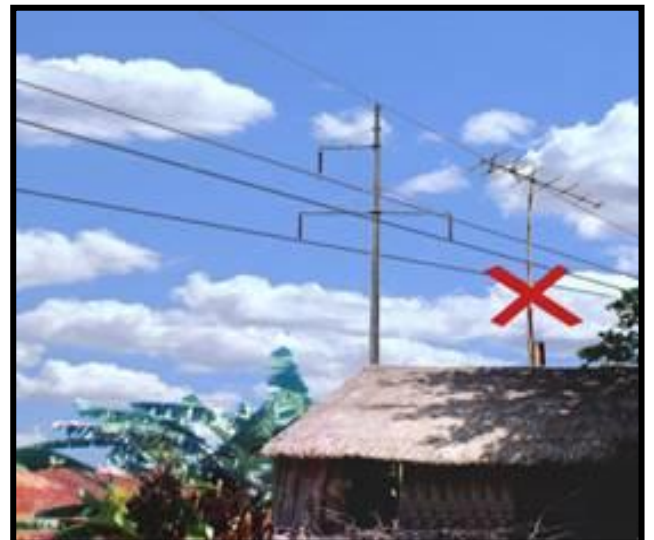
Mắc ăng ten thu sóng quá gần đường dây truyền tải là vi phạm khoảng cách an toàn
