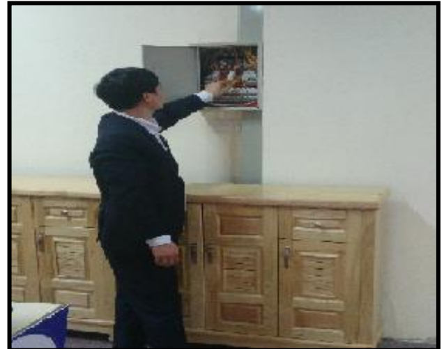
Ngắt thiết bị bảo vệ khi cần sửa chữa hay lắp thiết bị điện mới
