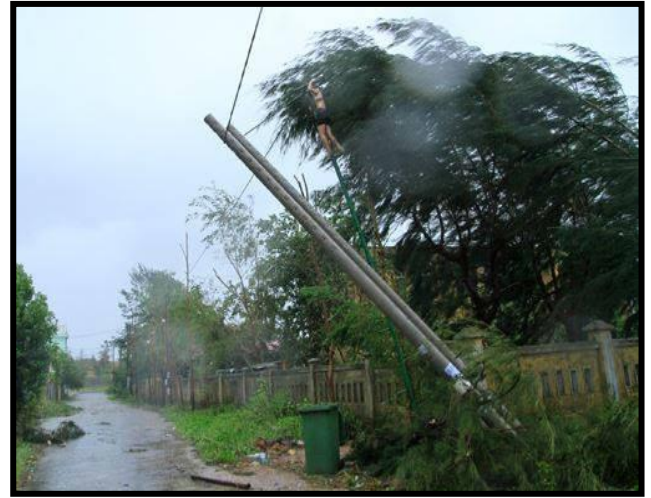
Bị mắc lên dây điện do ra đường khi giông bão lớn
